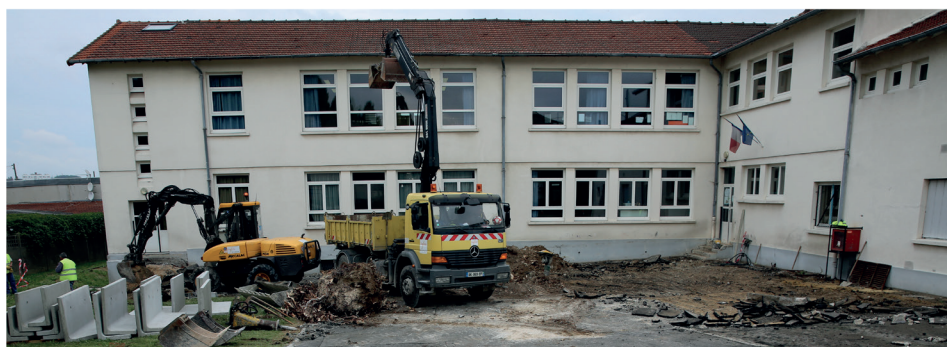
▲ L'école Irène Joliot-Curie profite maintenant d'une extension de sa cour d'école. Montant des travaux : 322 700 euros.
