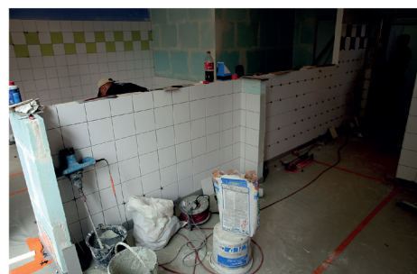
▲ L'école maternelle Jean Jaurès profite d'une rénovation de ses sanitaires. Montant des travaux : 99 393 euros.
