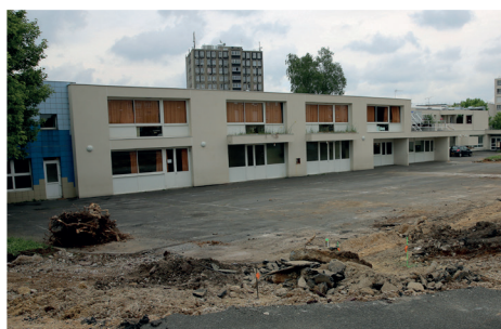
▲ L'école élémentaire Jacques Prévert bénéficie d'une cour totalement reconstruite. Montant des travaux : 385 000 euros.
