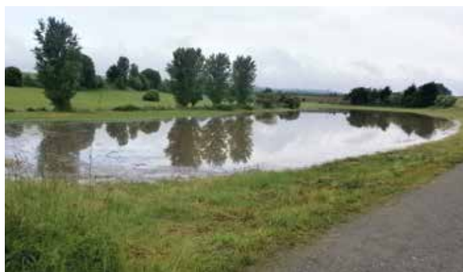
Digue de l'Orme du ramoneur de Moisselles
