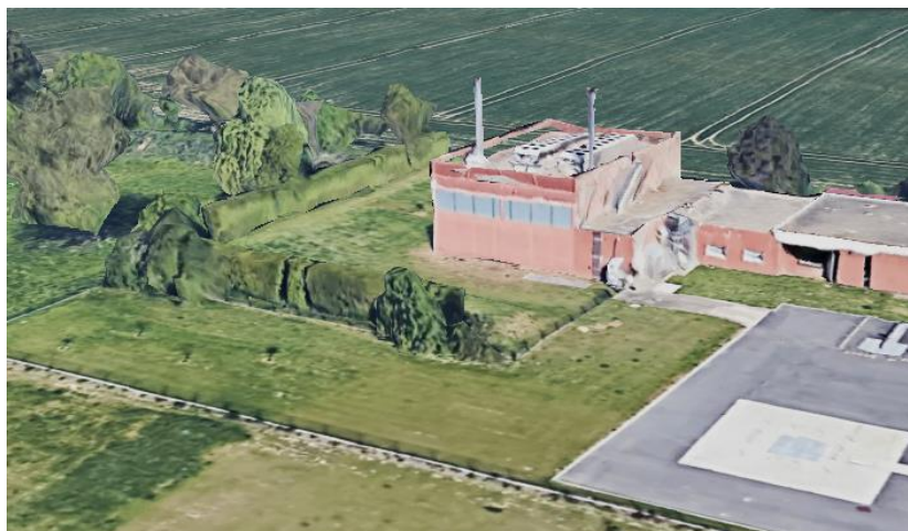
Figure 16 : STVLBG (Villiers-le-Bel) cheminée de 15 m
