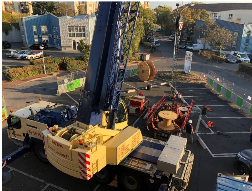
Figure 17 : intervention avec grue lors d'une remontée de pompe de production
