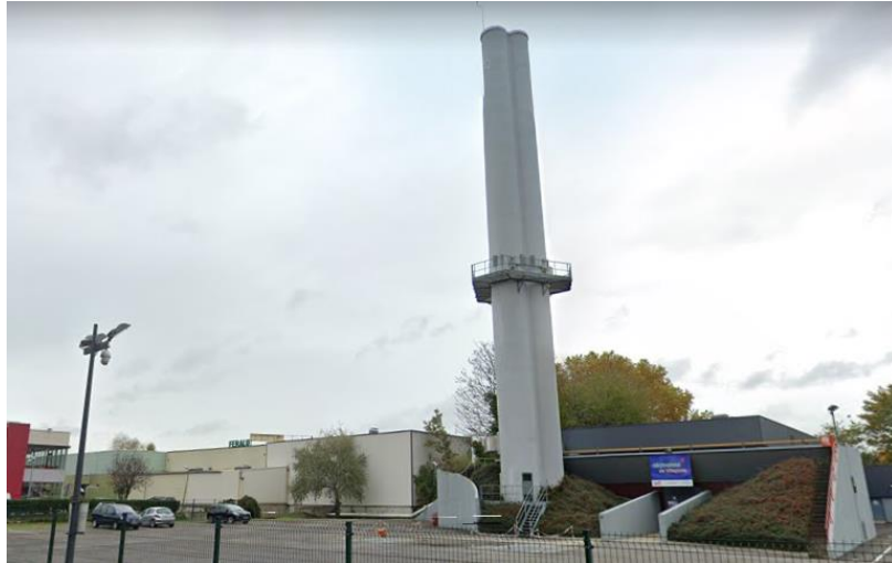
Figure 14 : Geopicta (Villepinte) cheminée de 32 m
