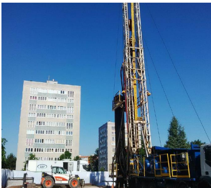
Figure 18 : appareil de workover en milieu urbain
