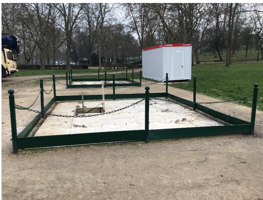
Figure 13 : emplacements de têtes de puits de forages géothermiques. Les têtes de puits se situent sous la surface du sol, dans une cave maçonnée et recouverte par une plaque de protection pour éviter tout risque de chute.
