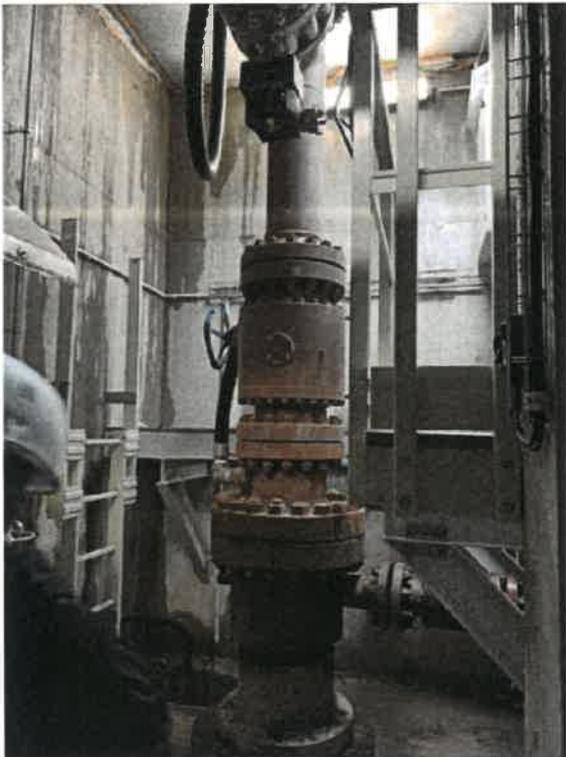
Figure 9 : illustration d'une tête de puits – partie visible des ouvrages
