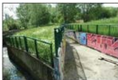
La confluence entre le Petit Rosne et le Croult est traitée de manière très technique via un système complexe de canaux (Garges-lès-Gonesse / Bonneuil-en-France)
