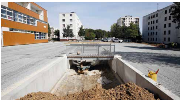
▲ Groupe scolaire Henri Barbusse : réfection de la totalité des murs, sols et plafonds; rénovation des sanitaires et reconstruction de la cour de l'école primaire Henri Barbusse A. Montant des travaux: 1565 400 €
