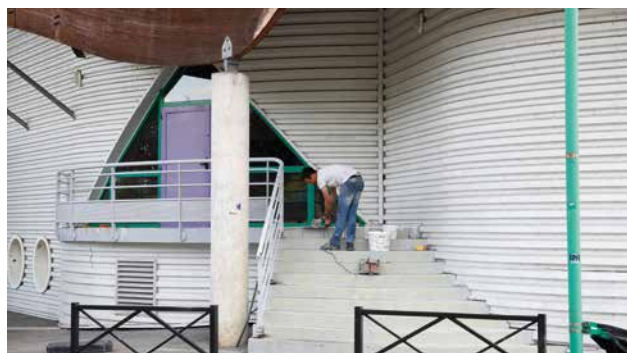
▲ Gymnase des Doucettes : remplacement du marquage au sol, du revêtement, des clôtures et des garde-corps; réfection de l'éclairage, de la façade extérieure et des murs et sols des vestiaires... Montant des travaux: 734 800 €
