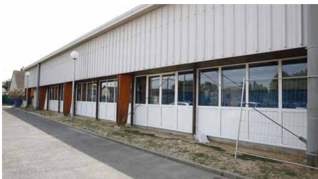
▲ Complexe sportif Jean Jaurès : remplacement de toute la plomberie, de la clôture et pare ballons, réfection des murs et sols du gymnase, création d'une ouverture pour les salles d'activité au rez-de-chaussée... Montant des travaux: 810 360 €
